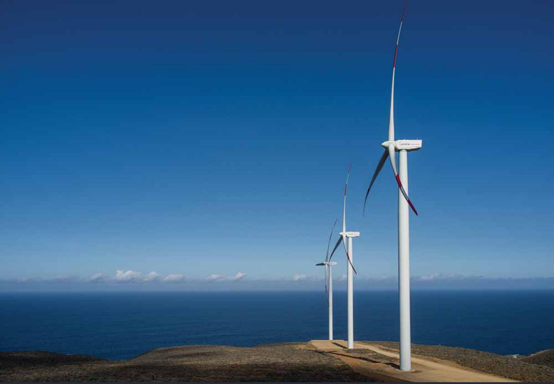
**Parque eólico de Punta Palmeras** (Chile) , de 45 MW, con 15 aerogeneradores AW116/3000 .
