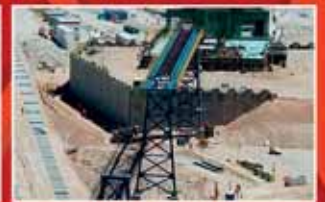
Muro Silo Chuquicamata Subterránea H=11m.
