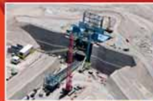
Muro Ministro Hales H=30m
