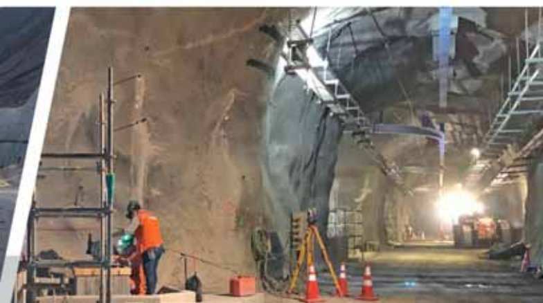
Codelco Chuquicamata Subterránea, Construcción, Montaje y Puesta en Marcha de Ventilación Secundaria Interior Mina, II Región, Chile.
