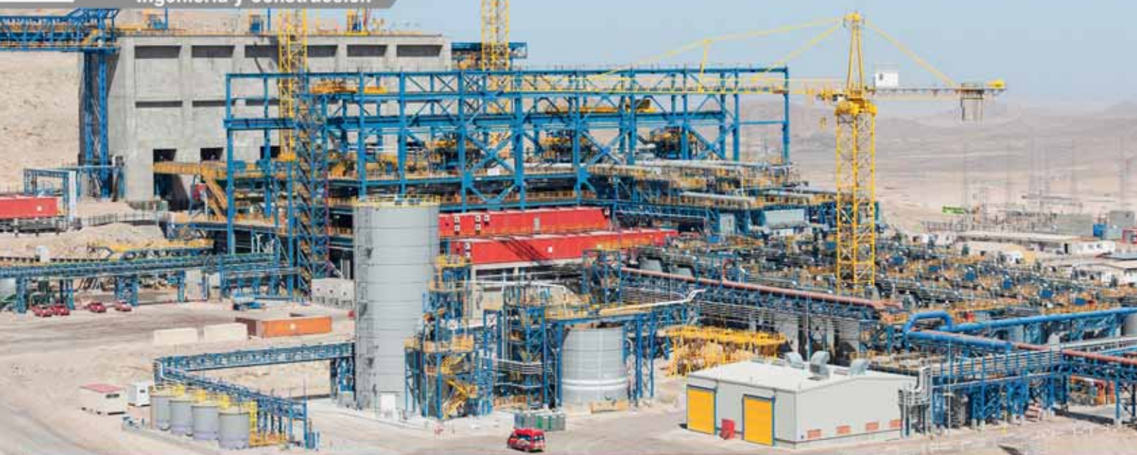
Sierra Gorda SCM, Construcción y Montaje Industrial Planta Concentradora, II Región, Chile.
