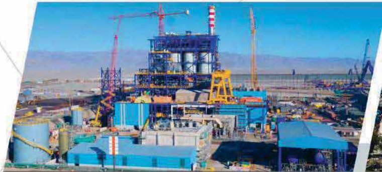
SK E&C, Central Termoeléctrica 375 MW, BOP y EPC Manejo Carbón, C.T. Red Dragon - Engle, Mejillones, II Región, Chile.
